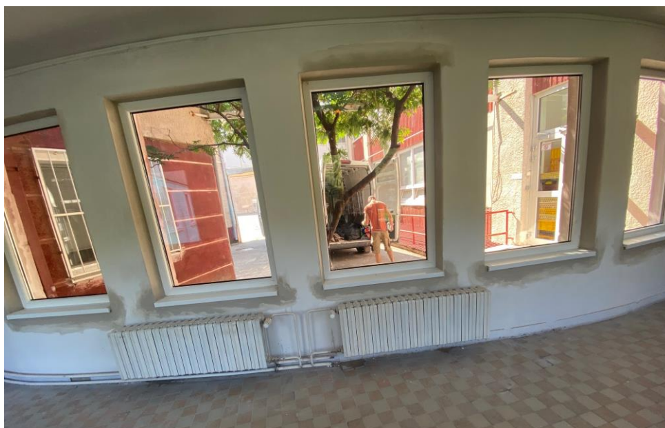
Výmena drevených okien za plastové na prechodovej chodbe
