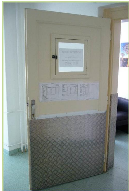
Oddelenie dlhodobo chorých Vymaľovanie chodby na oddelení a vstupu na oddelenie, oplechovanie dverí a rohov stien
