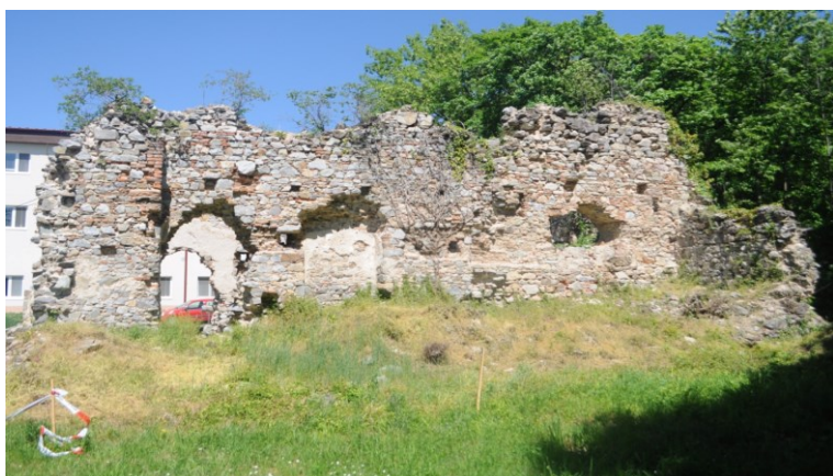
Ruina kostola sv. Jozefa pred rekonštrukciou
