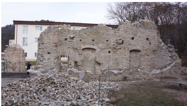
Ruina kostola sv. Jozefa po súčasnej rekonštrukcii
