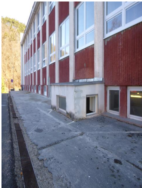
Čelná stena pred obnovou fasády
